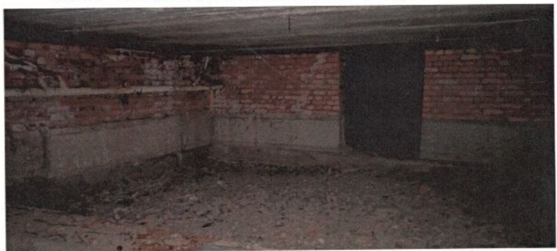
Фото 18 – Общий вид подвального помещения
