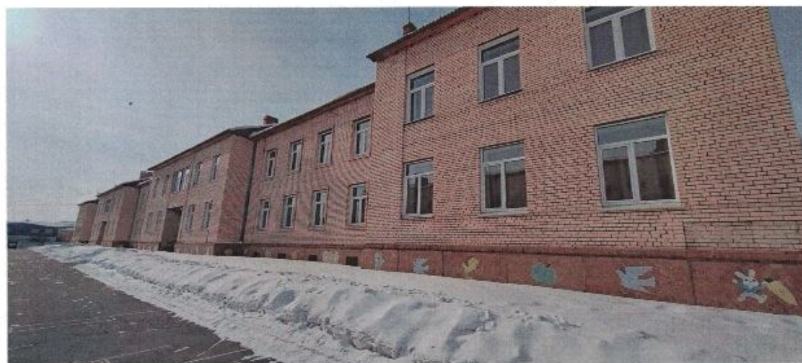
Фото 11 – Общий вид юго-западного фасада
