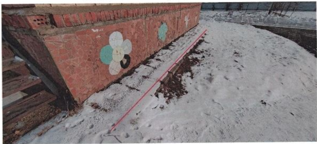
Фото 17 – Отмостка выполненная из бетонных прямоугольных блоков
