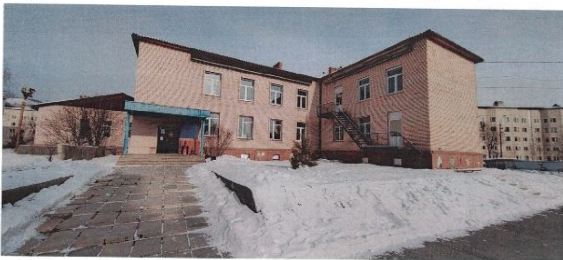
Фото 6 – Общий вид западного фасада
