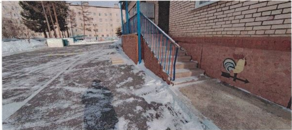
Фото 13 – Общий вид отмостки и асфальтобетонного покрытия
