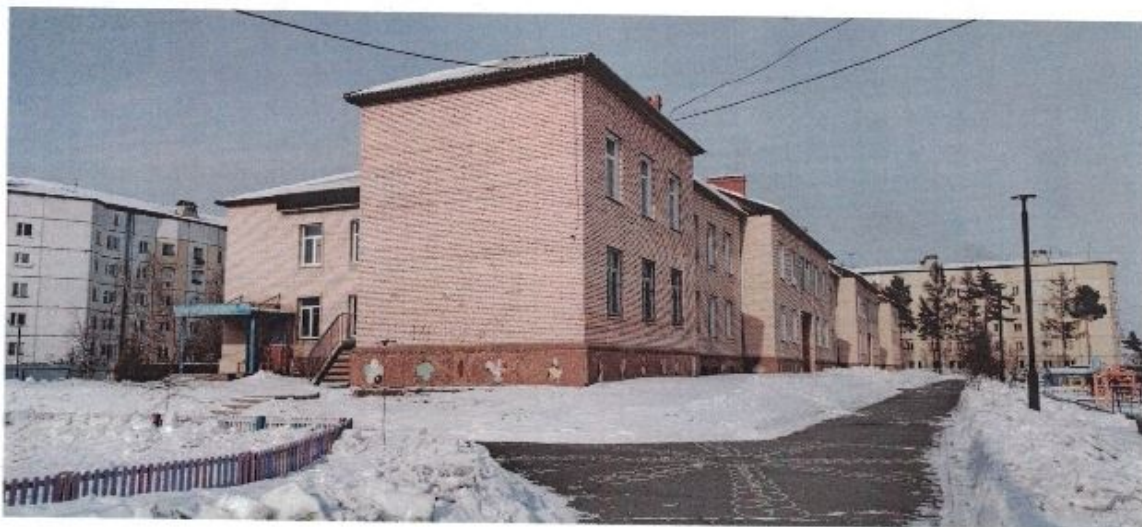
Фото 5 – Общий вид фасадов с юго-западной стороны
