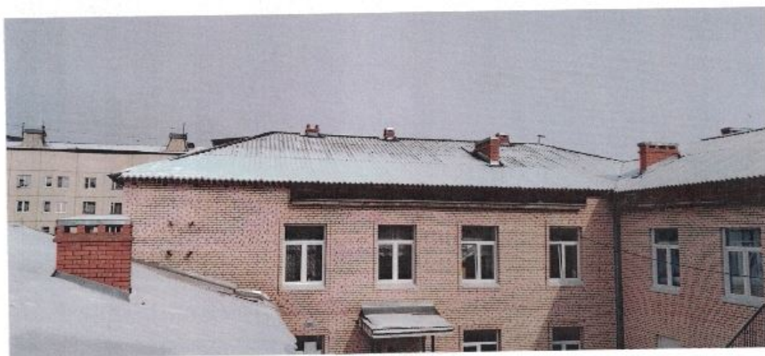
Фото 42 – Общий вид кровли
