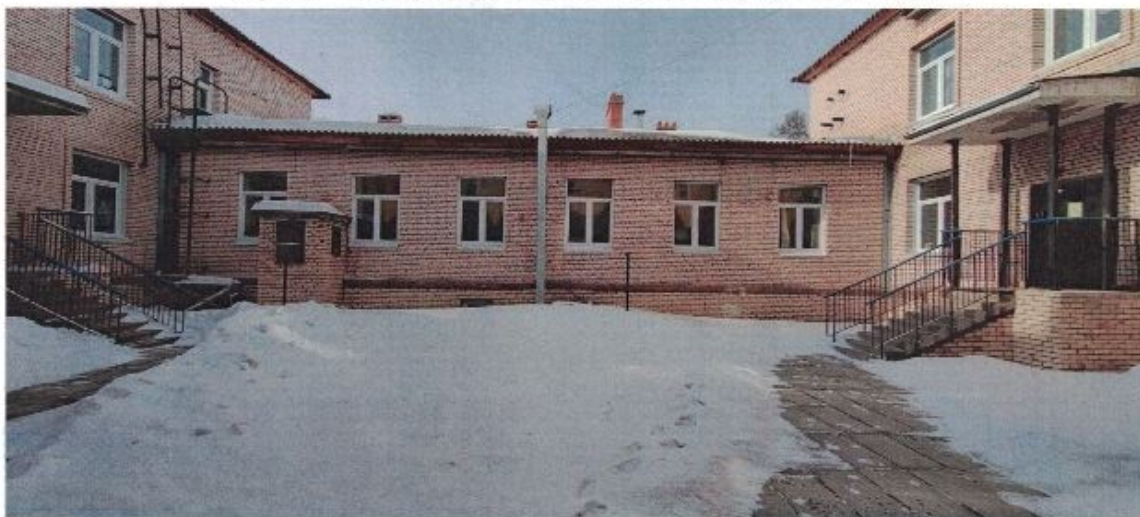
Фото 8 – Общий вид здания северо-западного фасада
